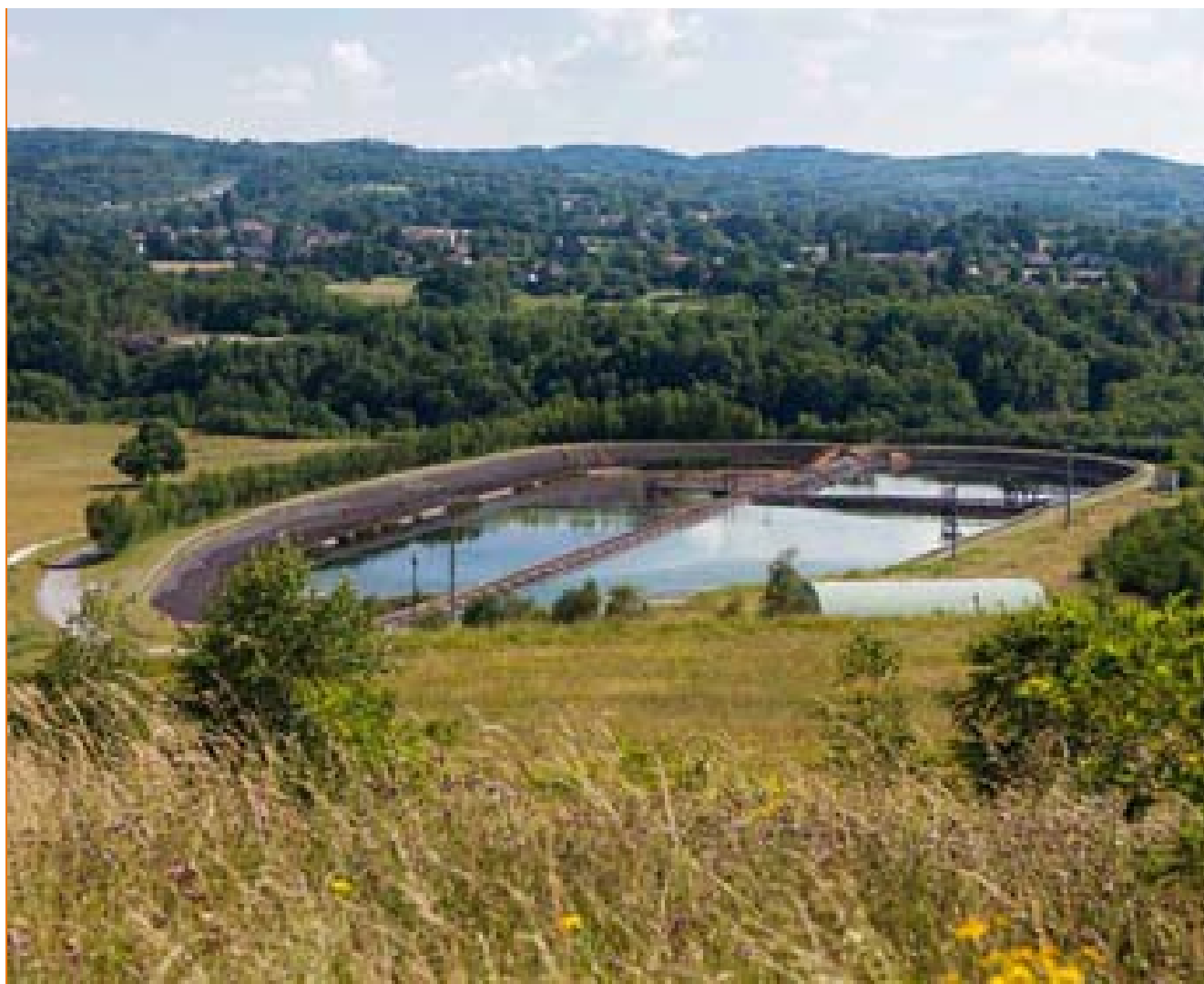
Figure V.4 - Bassin des eaux d'écoulement qui proviennent du site de stockage de résidus miniers d'uranium, site de Bessines-sur-Gartempe.
