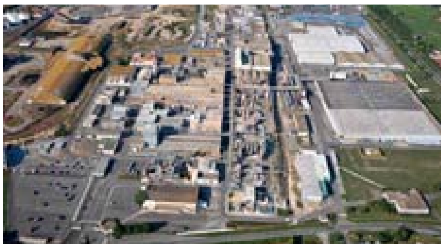
Figure VII.2 - Usine Rhodia de La Rochelle.
