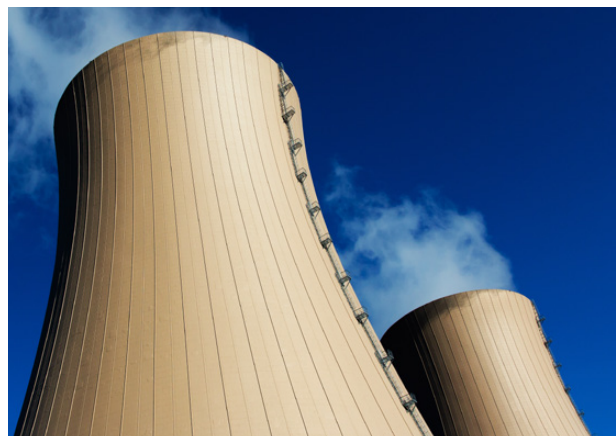
Centrale nucléaire : aéroréfrigérants
